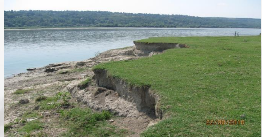
Снажна ерозија на на левој обали
