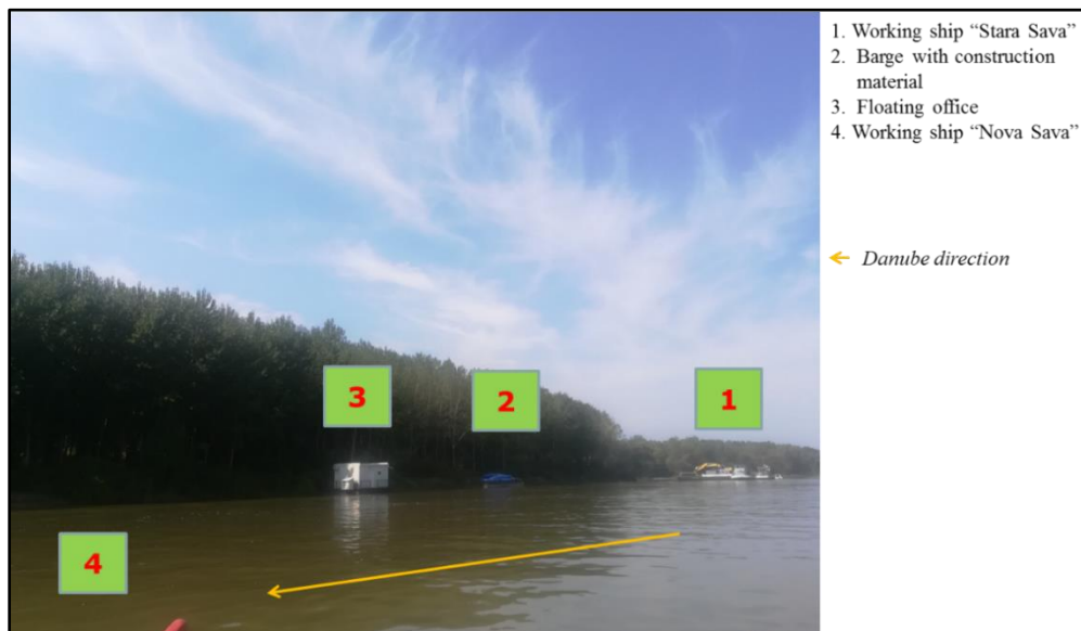
Слика 1 Приказ градилишта и помоћних објеката на критичном сектору Футог (подсектор Футог 2)
